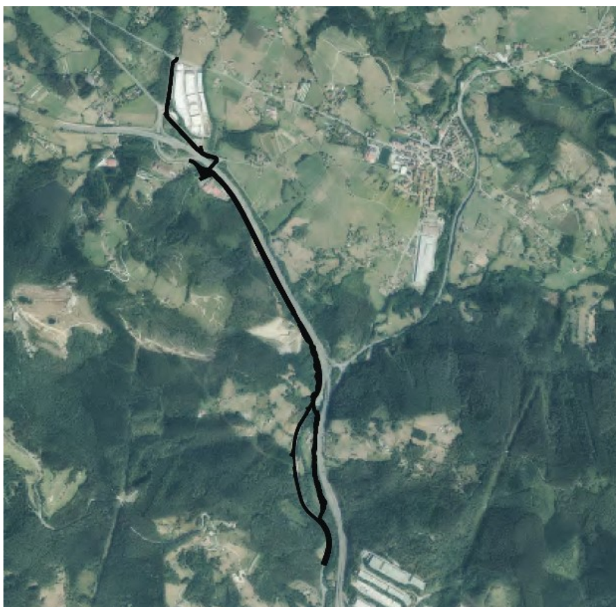
Vista general de la zona de actuación.
