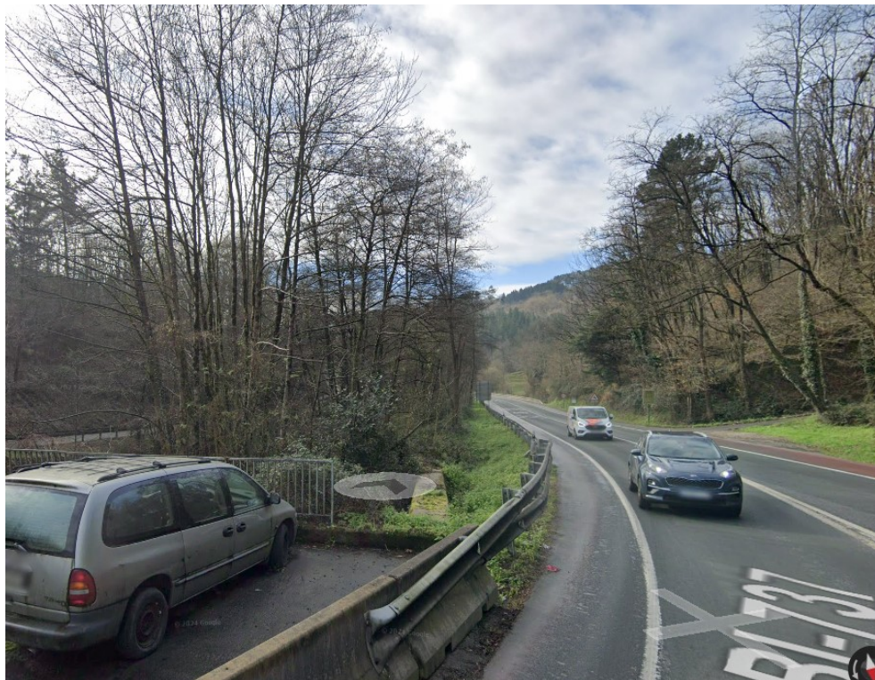
Vista de zona donde se proyecta la pila de la pasarela y alisos que serán podados en su parte superior.
